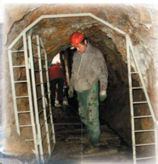
L'Argentière la Bessée : pose de grilles à chauves-souris devant l'entrée des mines
